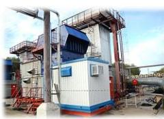
САУ ГПА предназначена для автоматического управления, регулирования и контроля защиты газоперекачивающего агрегата (газотурбинного энергоблока) на всех режимах работы, включая контроль технологических параметров и состояния исполнительных механизмов.
