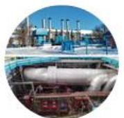
СТРОИТЕЛЬНО-МОНТАЖНЫЕ РАБОТЫ АСУ ТП И САУ НА КС МОКРОУС
