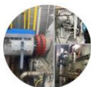
СТРОИТЕЛЬНО-МОНТАЖНЫЕ РАБОТЫ АСУ ТП И САУ НА КС АЛМАЗНАЯ
