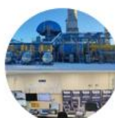
ПУСКОНАЛАДОЧНЫЕ РАБОТЫ АСУ ТП И САУ НА КС СКОВОРОДИНСКАЯ (МГ СИЛА-СИБИРИ)
